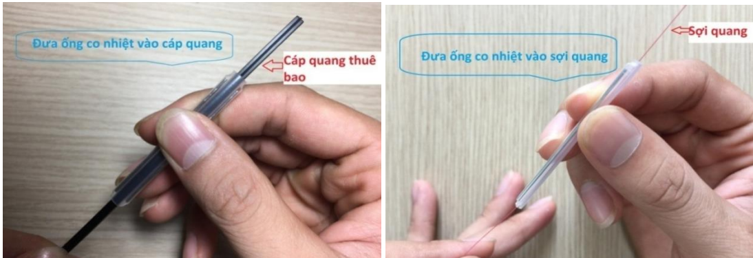
Hình 2.2: Luồn cáp quang hay sợi quang vào ống co nhiệt
